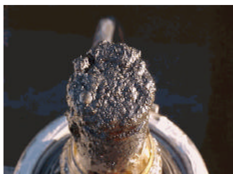
Figura 6. Resíduo e condensado sobre cupom de corrosão retirado do duto X.
