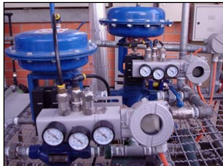
Figura 5. Posicionador de válvula.
