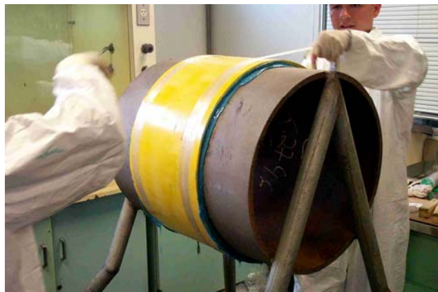
Figura 5. Material compósito 3 aplicado em um segmento de duto de aço
