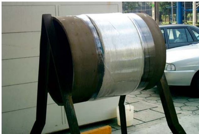
Figura 4. Material compósito 2 aplicado em um segmento de duto de aço
