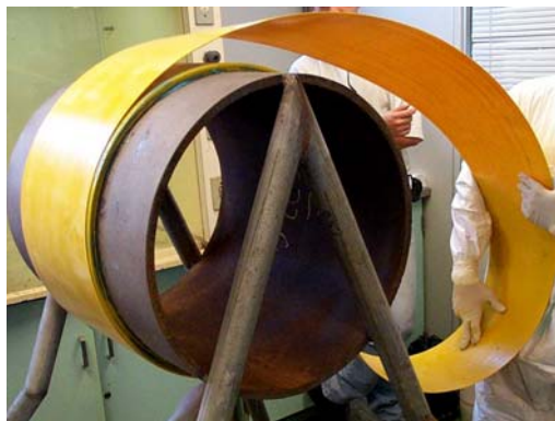
Figura 2. Exemplo de aplicação do material compósito 3 em um segmento de duto de aço
