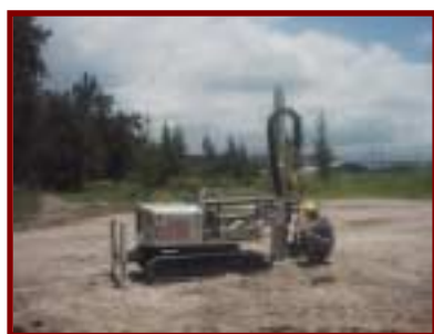
Figura 3 – Sondagem por cravação direta.
