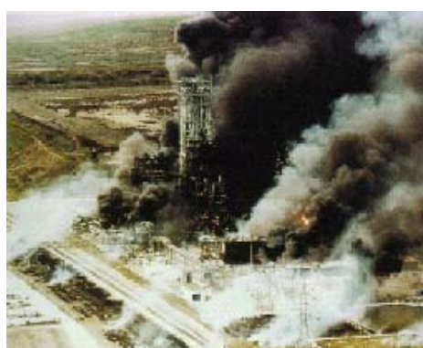
Figura 4. Explosão em Passadena, Texas
